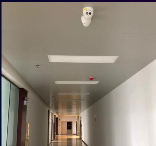
楼道安装的摄像头
